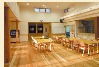
高齢者施設の構造材・造作材・仕上材にスギを使用
